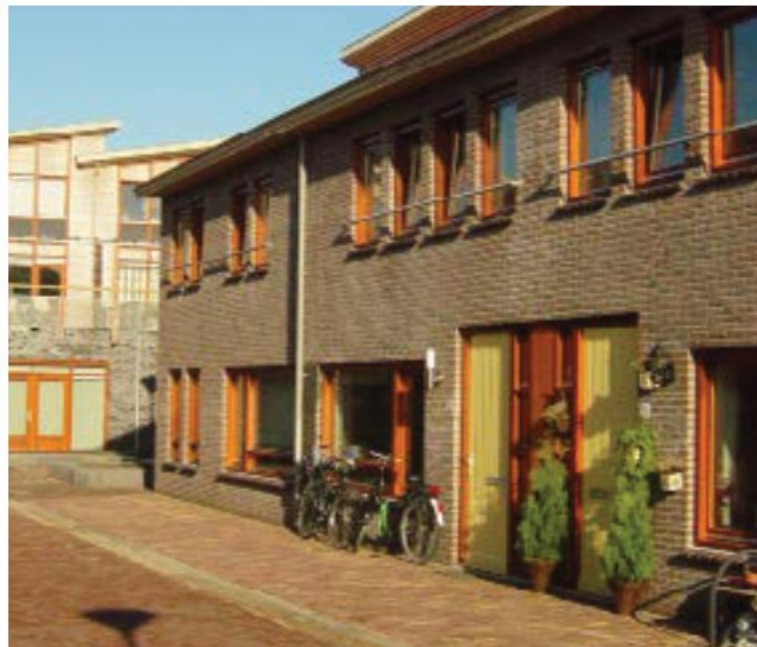
De voorgevels van de rijwoningen grenzen direct aan de stoep. Bij de inrichting van de stoep komt dit in kleur en materiaal tot uitdrukking.
