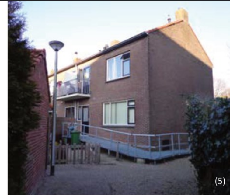
Bouwkundige en bouwfysische staat van de woningen laat te wensen over. Dit heeft ook impact op de openbare ruimte en de inrichting.
