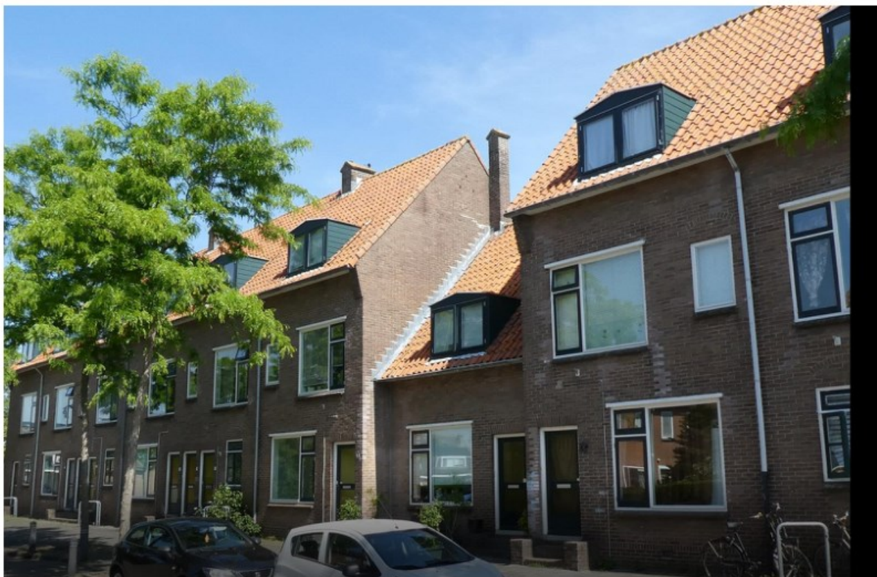
Figuur 17: gaten in kopgevel Schielandstraat 18-20, links één van de weinige bomen in de straat
