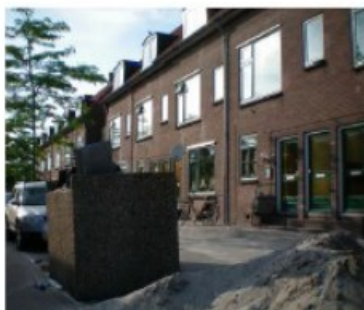
Op peil houden van de openbare ruimte vraagt onderhoud. Door bijplaatsing voorzieningen is weinig samenhang in de openbare ruimte.
