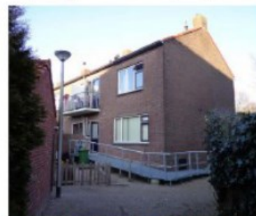
Bouwkundige en bouwtypische staat van woningen is slecht. Dit heeft impact op de openbare ruimte en de inrichting.
