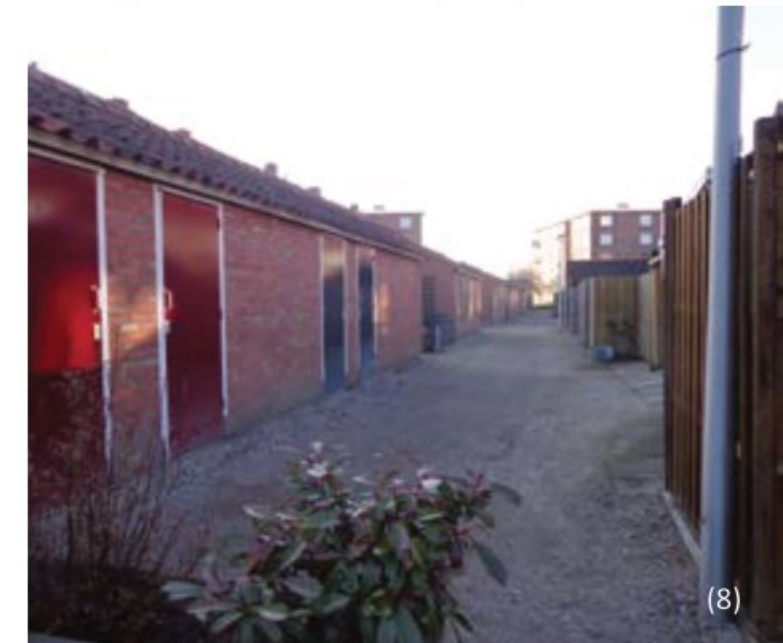
De achterpaden zijn verzakt ligging en door de materiaalkeuze, een kale, onaantrekkelijke uitstraling. Wegens onduidelijke verantwoordelijkheden en rechten verrommelen de achterpaden.
