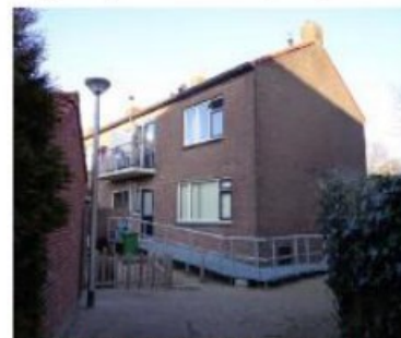
Bouwkundige en bouwfysische staat van woningen is slecht. Dit heeft impact op de openbare ruimte en de inrichting.
