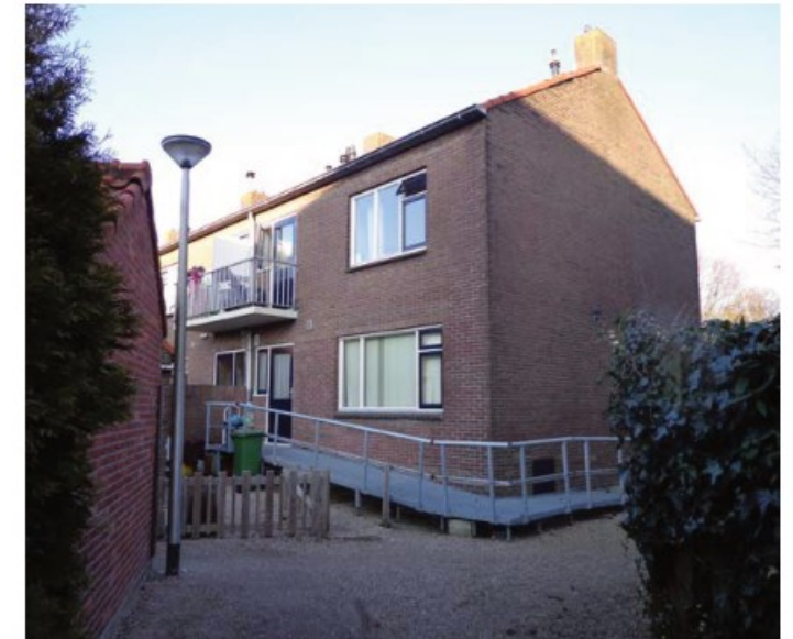
Bouwkundige en bouwfysische staat van woningen is slecht. Dit heeft impact op de openbare ruimte en de inrichting.
